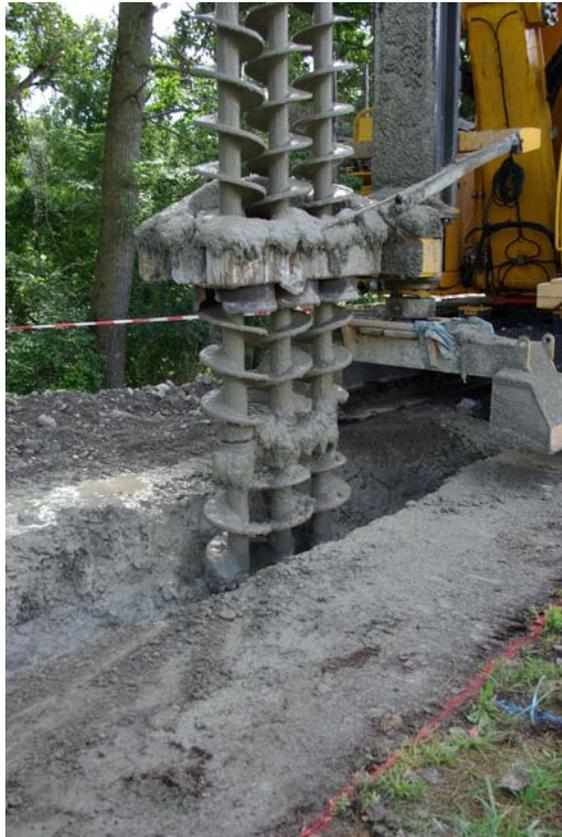
**Le renforcement de la digue sera assuré en majeure partie par la réalisation d'un mur en béton de sol. Le procédé consiste à mélanger les graviers, sables et limons présents dans la digue avec de l'eau et du ciment. Le mur ainsi constitué à l'intérieur de la digue évite sa rupture en cas de crue.**
