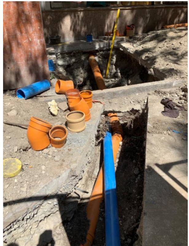
Abb. 10 : Bau eines Trennsystems in Sitten
