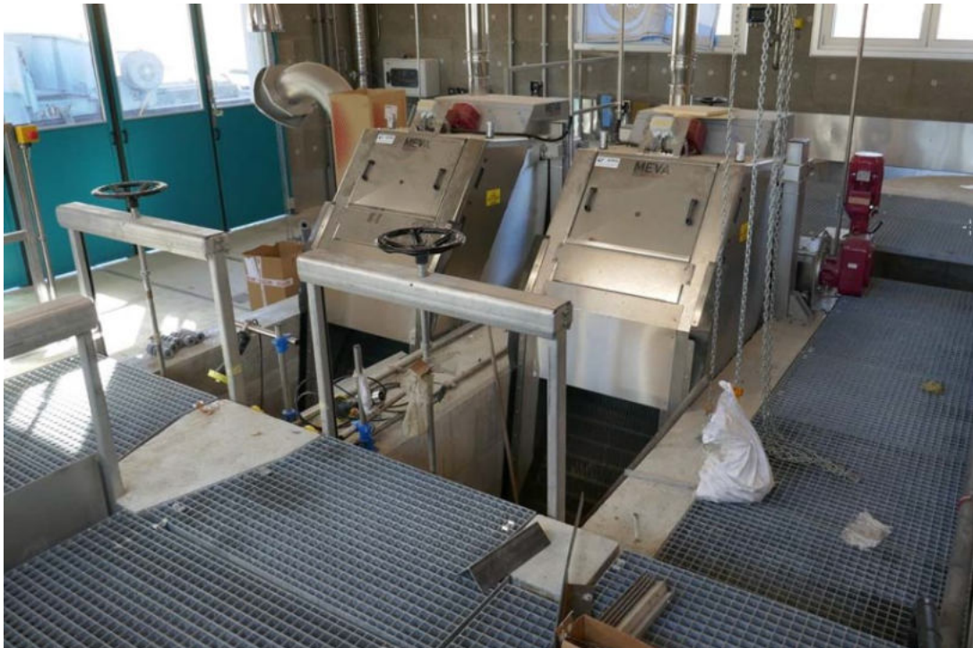
Abb. 22 : Neue Feinrechen der ARA Vétroz-Conthey
