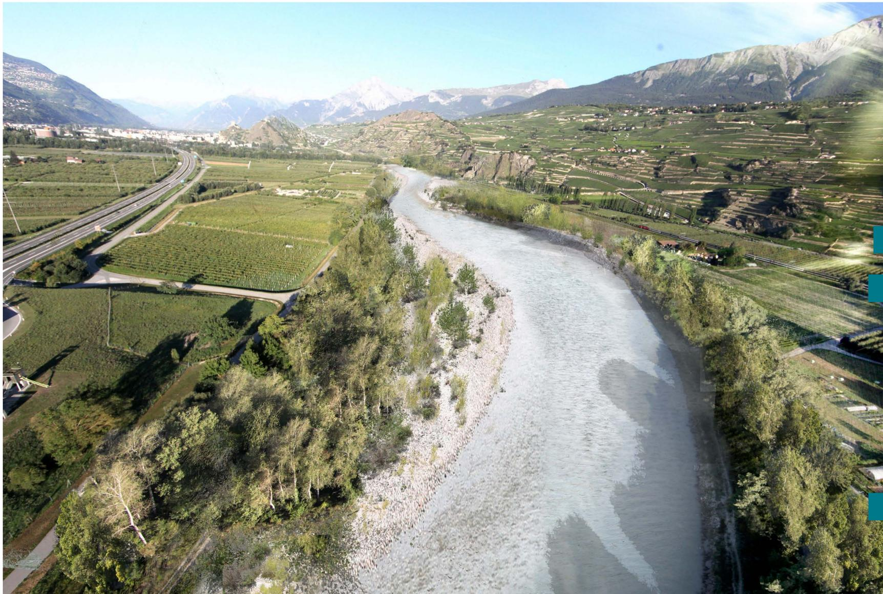
L'élargissement du fleuve vers la rive droite, à l'amont de l'embouchure de la Borgne, se fera par «ripage». Après avoir construit la nouvelle digue protégeant les personnes et les biens contre les crues, le Rhône pourra se déplacer et s'élargir progressivement, jusqu'à la limite fixée par la digue.
