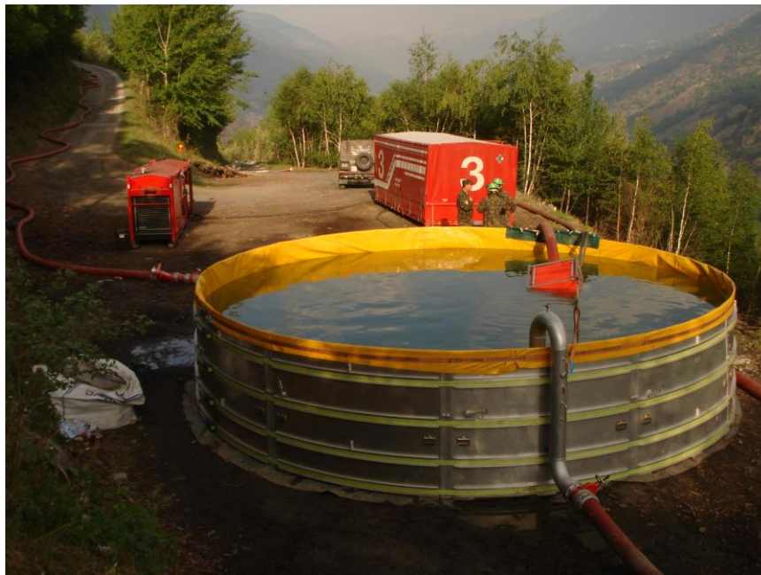
Bassins d'accumulation, lances, motopompes et conduites d'eau (Viège 2011)
