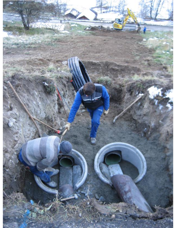
Figure 9 : Pose de collecteurs séparatif à Riod
