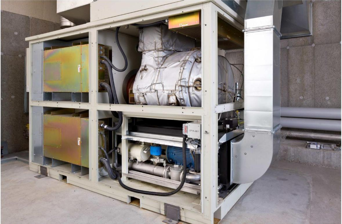
Abb. 16 Turbine des BHKW von der ARA Sierre-Noës : Grünstrom für 250 Haushalte (Foto Sierre-Energie)
