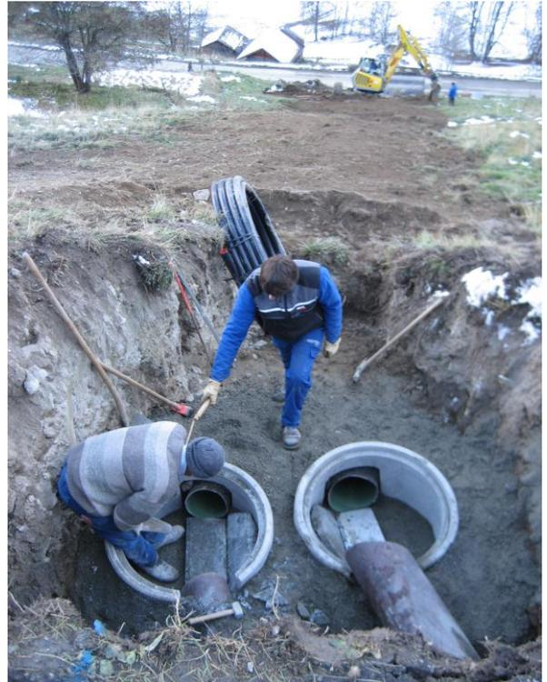
Abb. 9 Trennsystemkanalisation Verlegung in Riod
