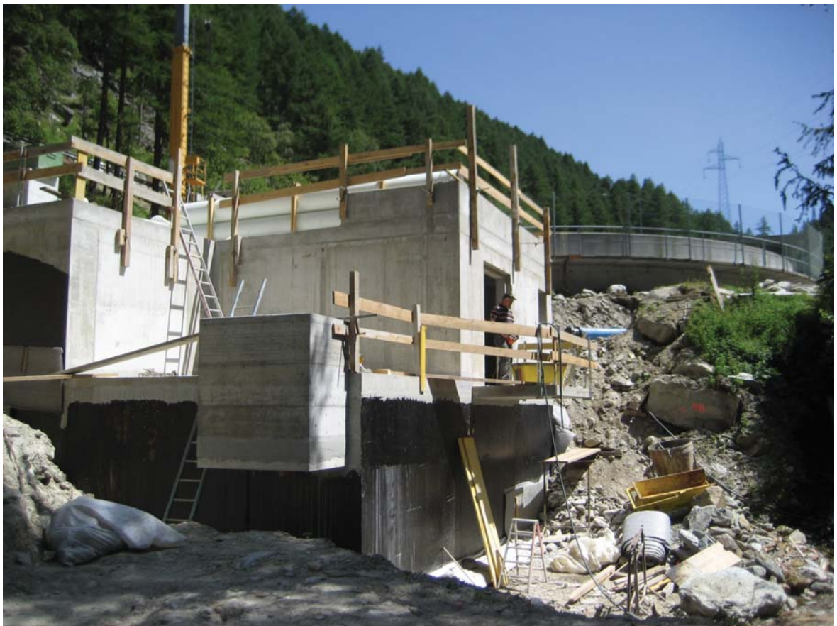
Figure 12 : STEP Saastal, gros œuvre STAP vers le captage de l'usine hydroélectrique KW Ackersand I AG, pour rétablir la qualité des eaux de la Saaser Vispa
