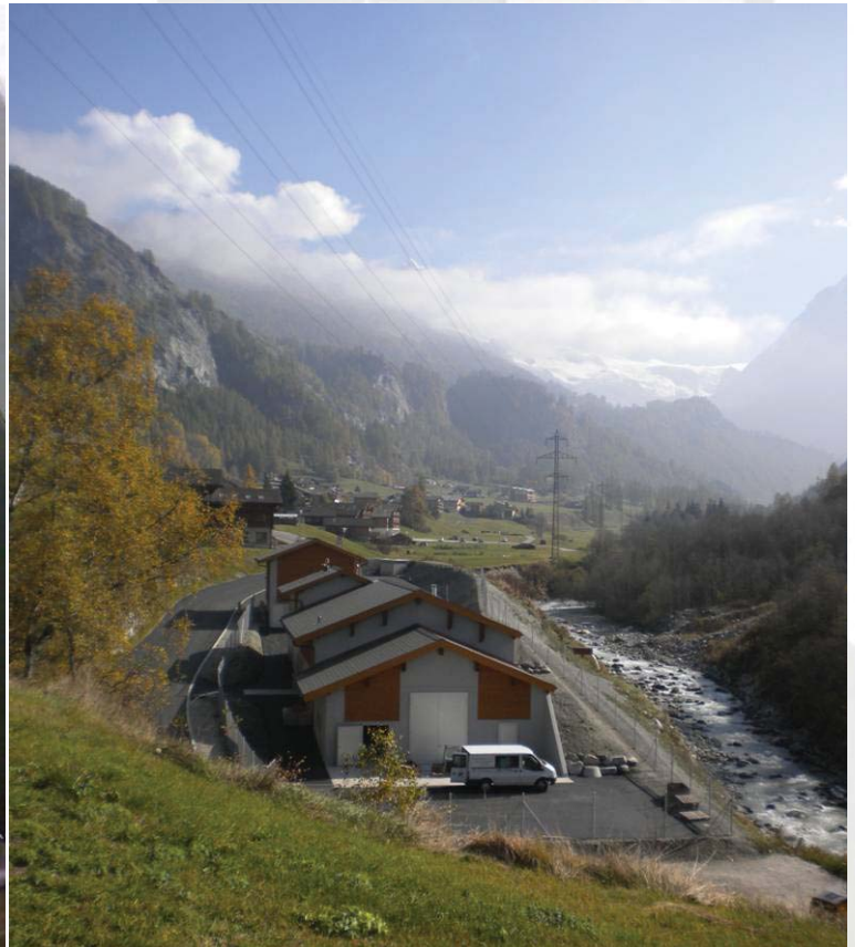
STEP d'Evolène : 6'000 EH avec nitrification, mise en service décembre 2010
