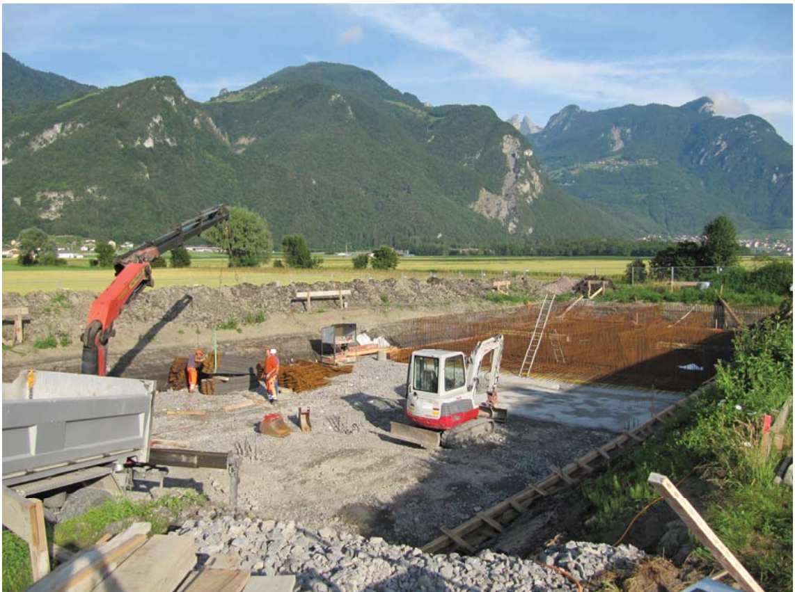
Figure 11 : STEP Vionnaz, terrassements bassins biologiques
