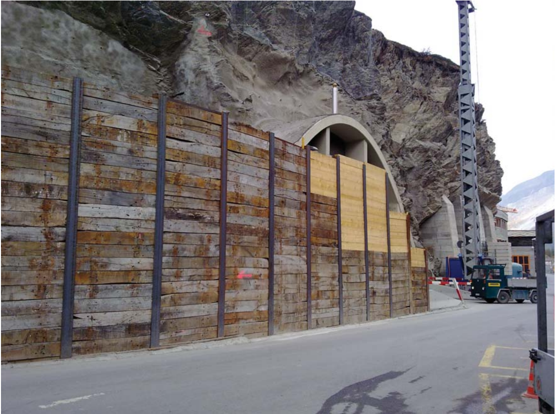
Figure 5 : Travaux STEP de Zermatt
