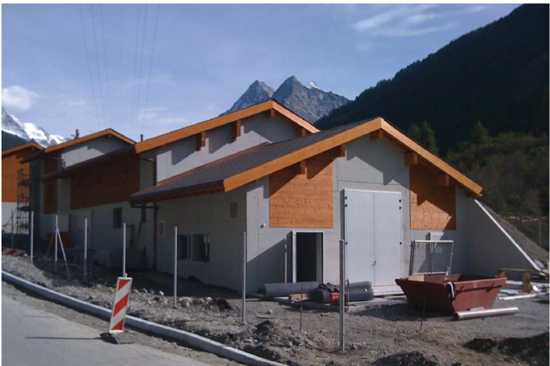
Figure 1 : STEP d'Evolène à la fin des travaux
