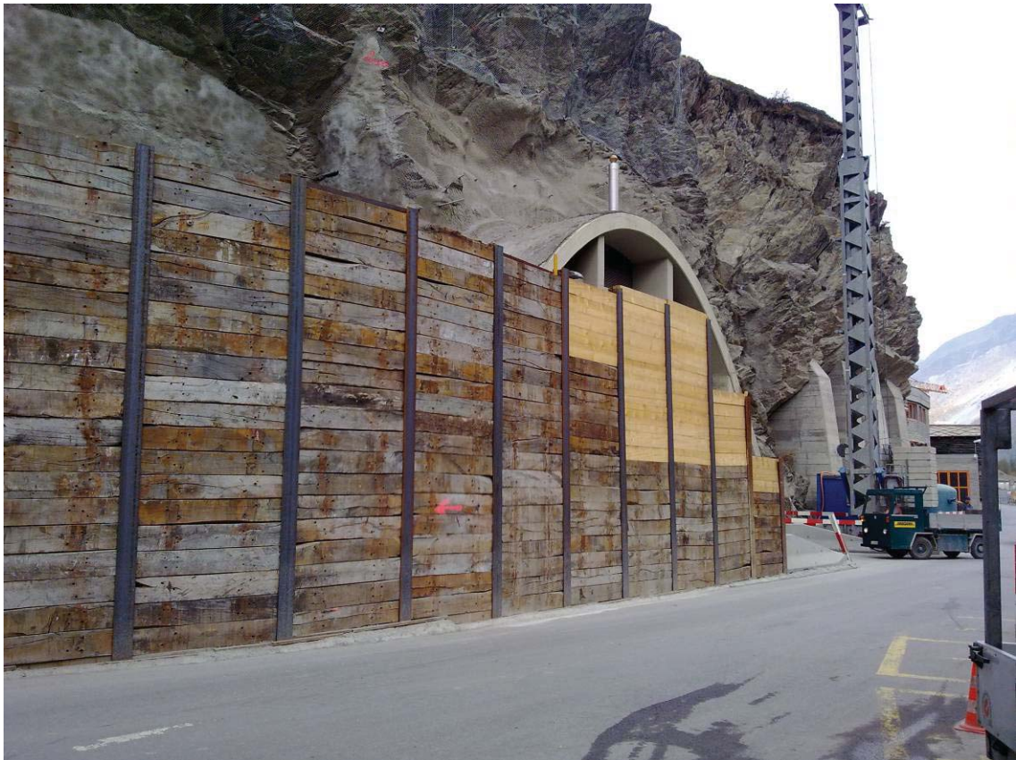
Abb. 5 : Ausbau ARA Zermatt
