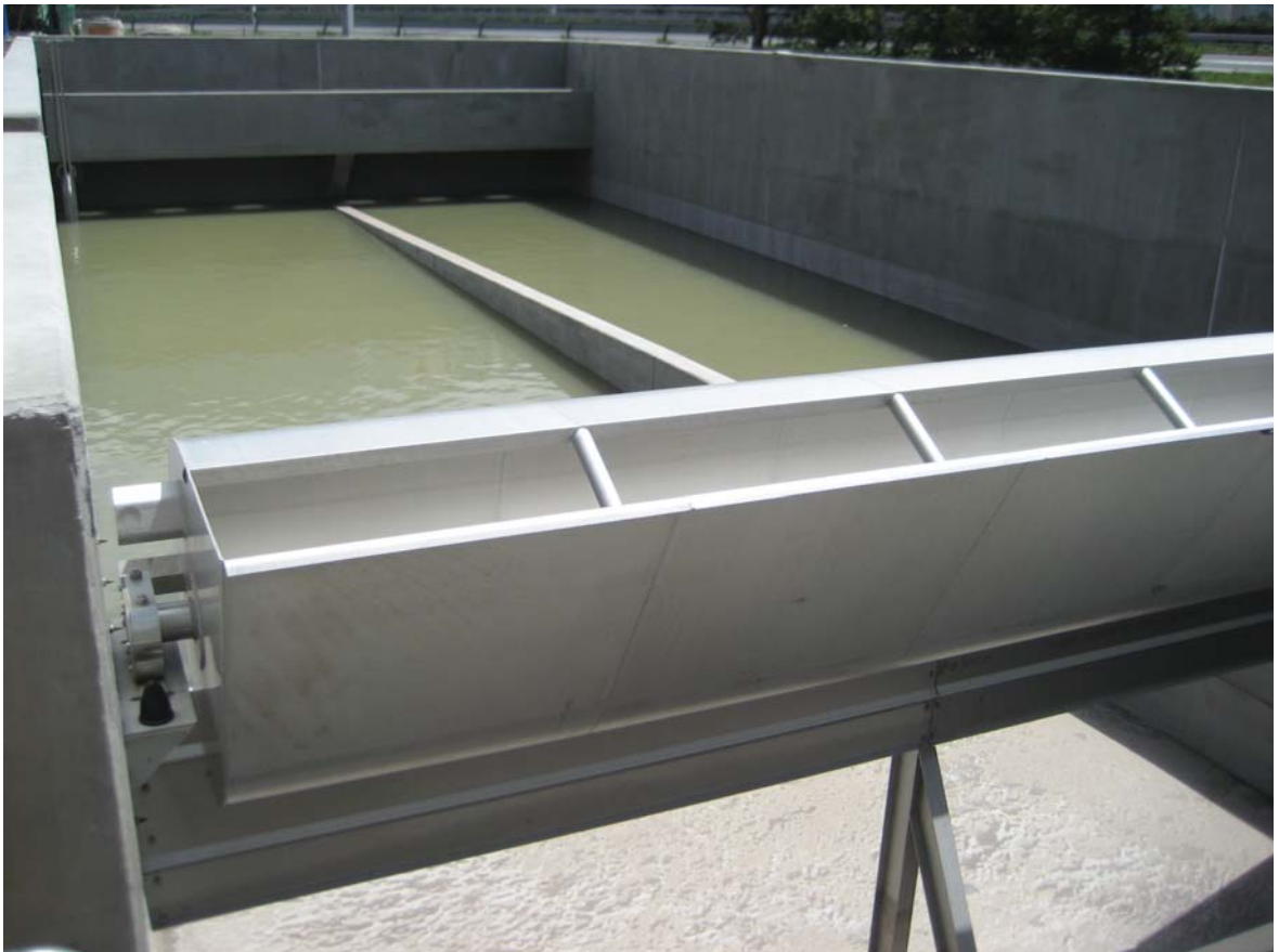
Abb. 6 : Ausbau ARA Martigny, neue RKB
