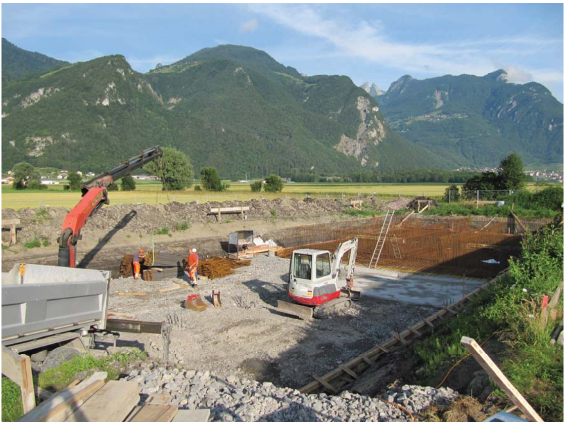
Abb. 11: ARA Vionnaz, Aushub für die biologischen Becken
