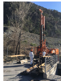
Neubau zusätzlicher Sicherungsbrunnen C17 zvg Lonza
