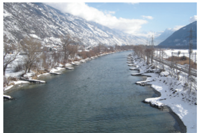
Foto 3: Bühnen aus der ersten Rhonekorrektur bei Turtmann (Februar 2005).
