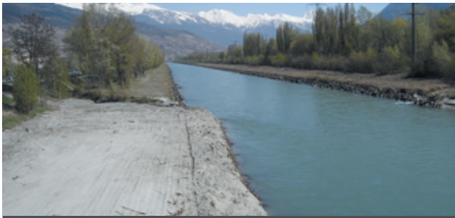
Abb. 18: Heutiger Unterhalt des Hochwassergerinnes. Künftig wird die Rhone ihr Gerinne auf der Regimebreite selbst frei von Bewuchs halten.
