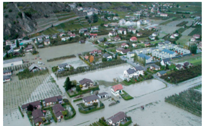
Foto 1: Dammbuch und Überschwemmung. Rechtes Ufer der Rhone, Saillon, Oktober 2000.
